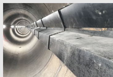
Schmutzwasser-Düker unter der Elbe während der Bauzeit (Die Neonröhren wurden nur für die Bauphase montiert)
