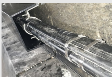
Schmutzwasser-Düker unter der Elbe während der Bauzeit (Die Neonröhren wurden nur für die Bauphase montiert)
