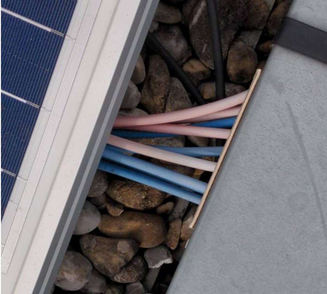
Décoloration des câbles solaires (colorés), le rouge en particulier se décolore très rapidement (source : Robert Kröni)
